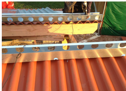
Fixation des éléments UBAK sur la couverture
