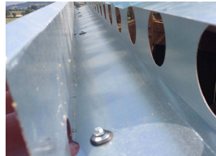
Fixation avec vis D. 6,5 x L. 130
