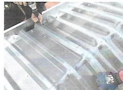
Assemblage des 2 lanterneaux à l'aide des vis de couture avec manchon prémonté D. 9,6 x L. 18
