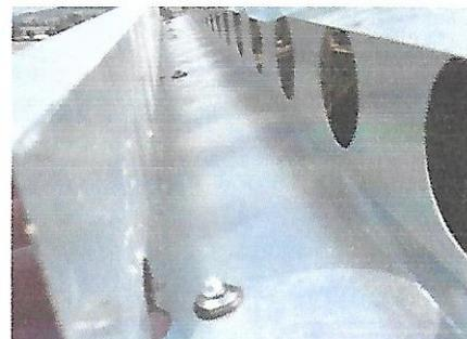
Fixation avec vis D. 6,5 x L. 130
