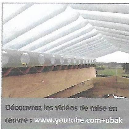
**ATTENTION** : Pour les deux supports, la fixation doit être modérée pour ne pas écraser le joint.
