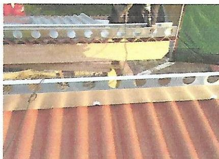
Fixation des éléments UBAK sur la couverture
