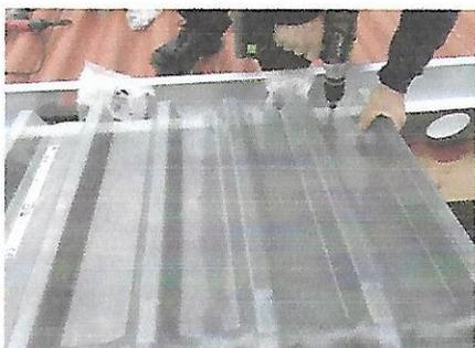
La fixation des lanterneaux sur les éléments UBAK à l'aide des vis de couture
